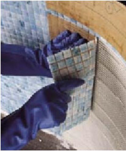
Укладка мозаики (2 x 2) в плавательном бассейне
